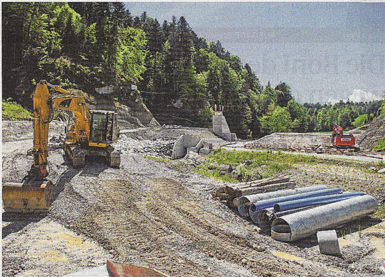
Der Bagger baut an der Rampe der Strasse, die dann auf der Höhe der Dammkrone quer über das Lauterbachtal führen wird. Fotos: Raphael Moser
