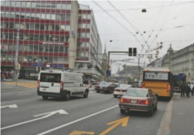
7: Anstelle der Fahrt geradeaus zum Bahnhofplatz führen zwei Linksabbiegespuren in Richtung Schanzenstrasse. Im Bild rechts ist die temporär installierte Bushaltestelle zu erkennen.
