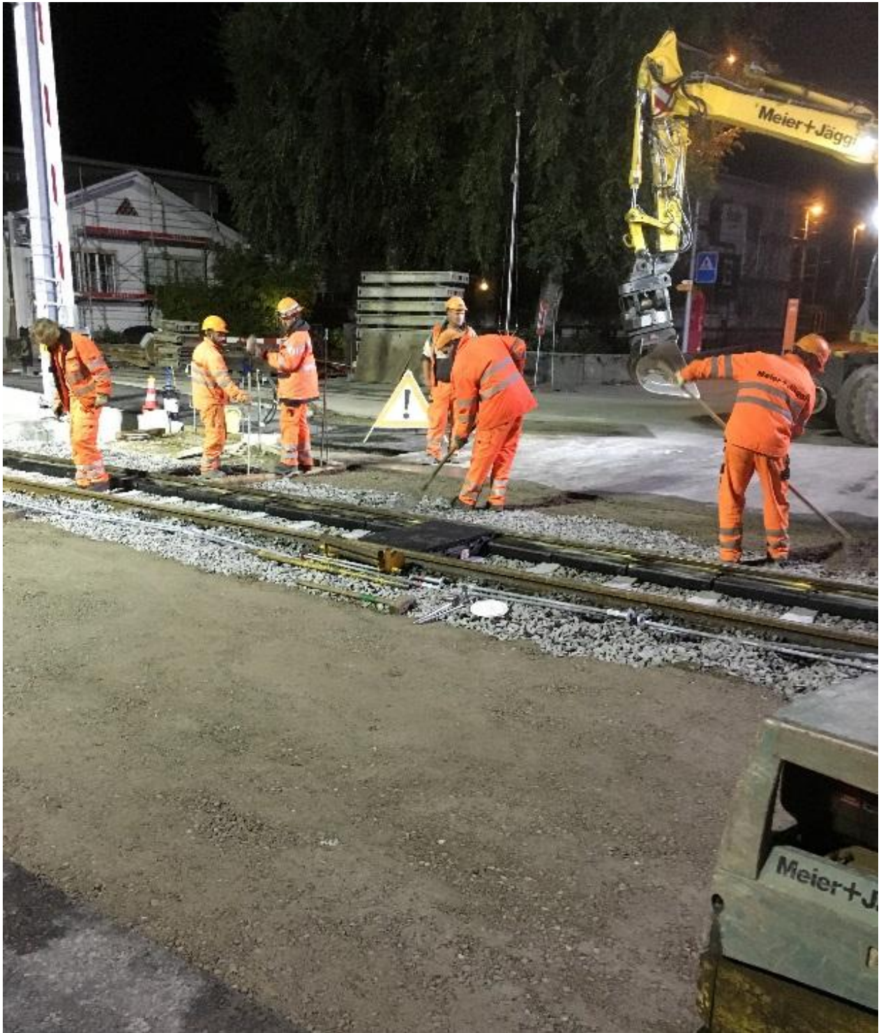
Unterbausanierung beim Bahnübergang.
