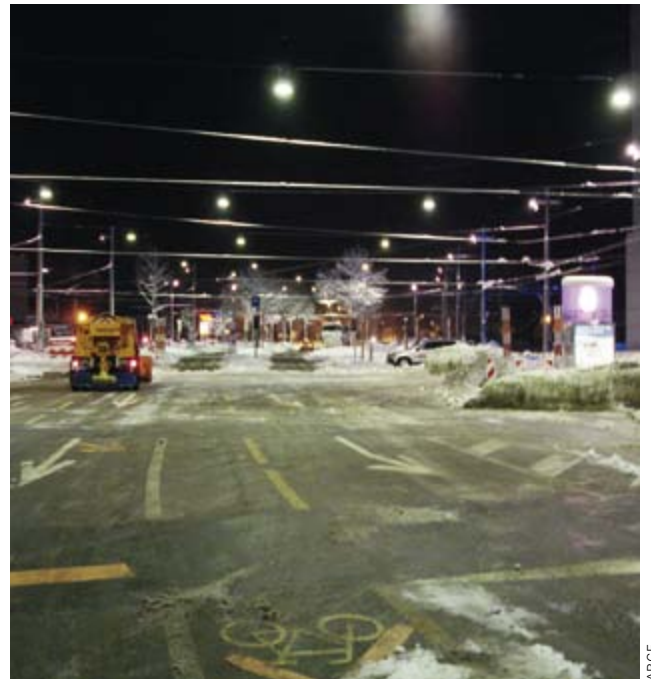
10: Bereich Guisanplatz, 18.12.2009, 01.30 Uhr. 3-stündige Schneeräumungsarbeiten vor Wiederherstellung des Guisanplatzes (Signalisation, Markierung, LSA). Die Umstellung der Verkehrsprovisorien erfolgte jeweils nachts über, mit Hilfe eines Verkehrsdienstes.
