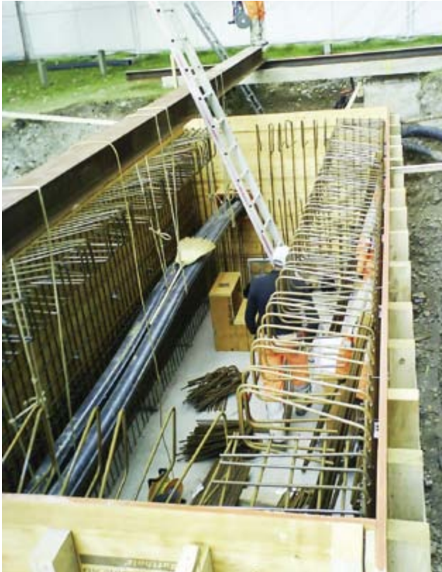
5: Kabelzugschacht (Elektro) in Ortsbeton. Wurde über den Bestand gebaut.
