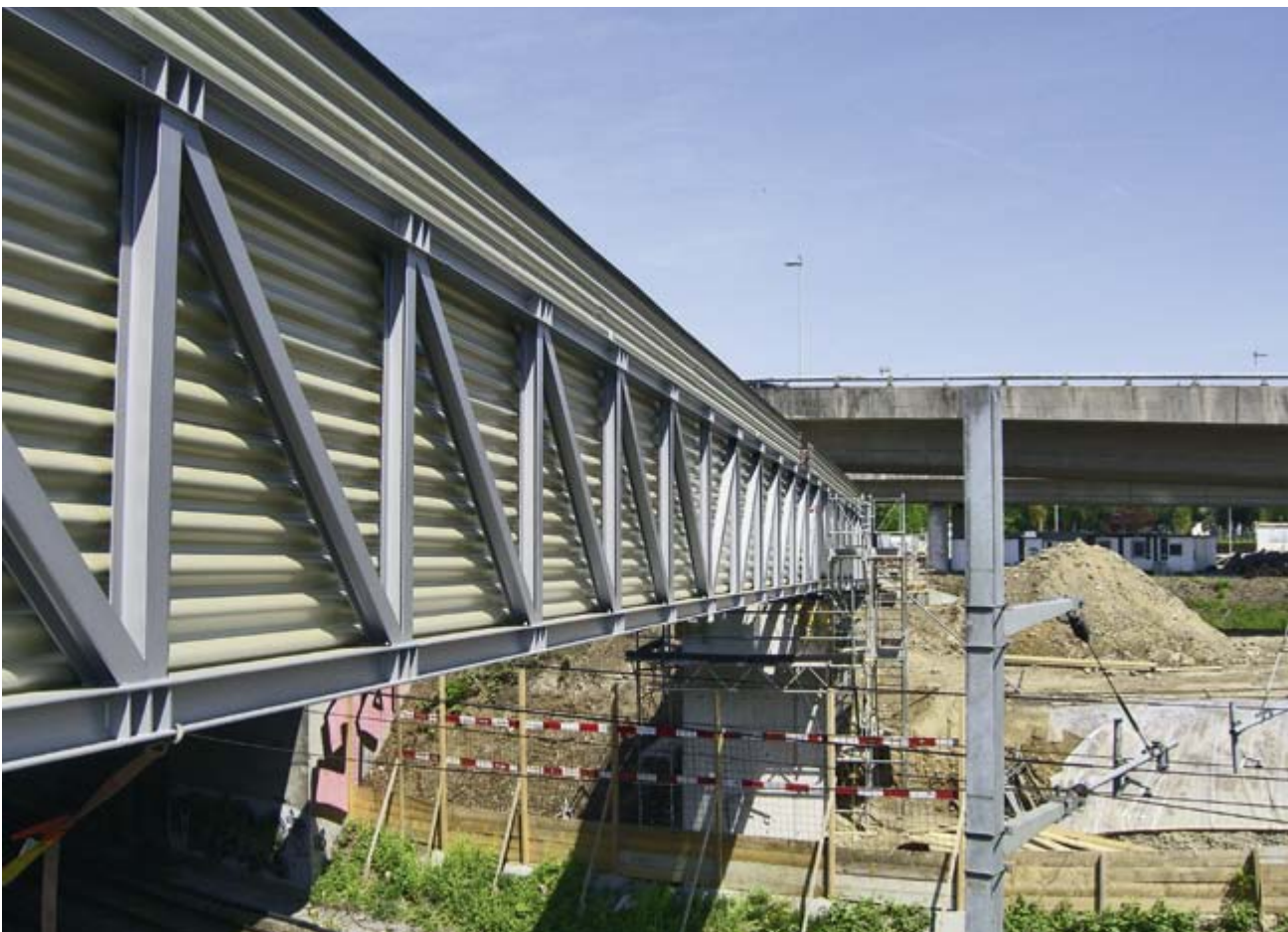
8: Im August 2009 fertiggestellte Werkleitungspasserelle (Medien: Gas, Wasser, Elektro, Telecom). Blick Richtung Norden. Überquerung von 2 SBB-Linien und Autobahn sowie Unterquerung Autobahnrampen.
