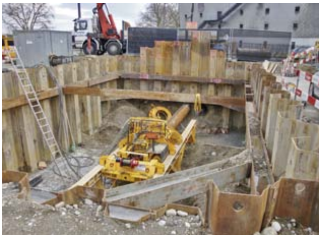
6: Querung Winkelriedstrasse (März 2009), Blick Richtung Süden. Startgrube mit Bohrpressmaschine. Medien: Gas/Wasser. Die Bohrungen überqueren hier den bereits im Januar 2009 mitten in der Winkelriedstrasse erstellten Düker für Strassenentwässerung.
