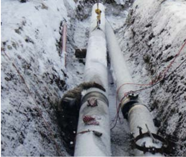
9: Grabenbau entlang der Papiermühlestrasse. Schweissarbeiten im Schneetreiben.
