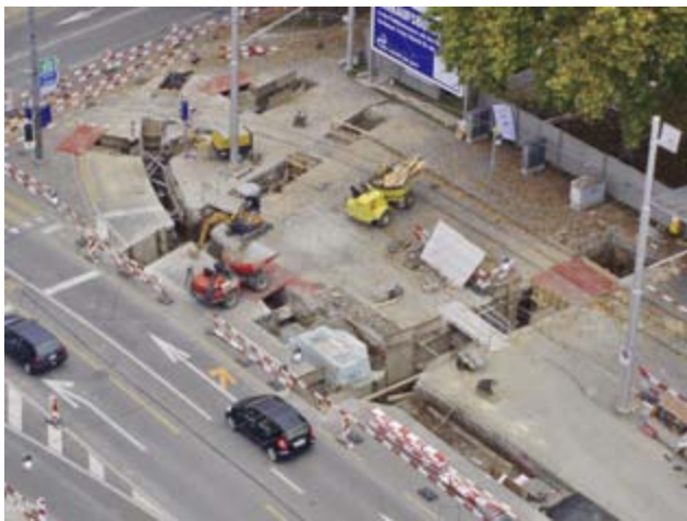
3: Werkleitungsumlegung Guisanplatz. Zahlreiche kleine Angriffspunkte mit entsprechenden Verkehrsprovisorien. Aufnahme Oktober 2008. In einer 1-wöchigen Periode wurde der Trambetrieb durch Busbetrieb ersetzt.
