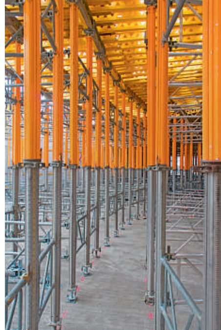
Detailaufnahme der Schalung: Doppeljoche, so weit das Auge reicht.
