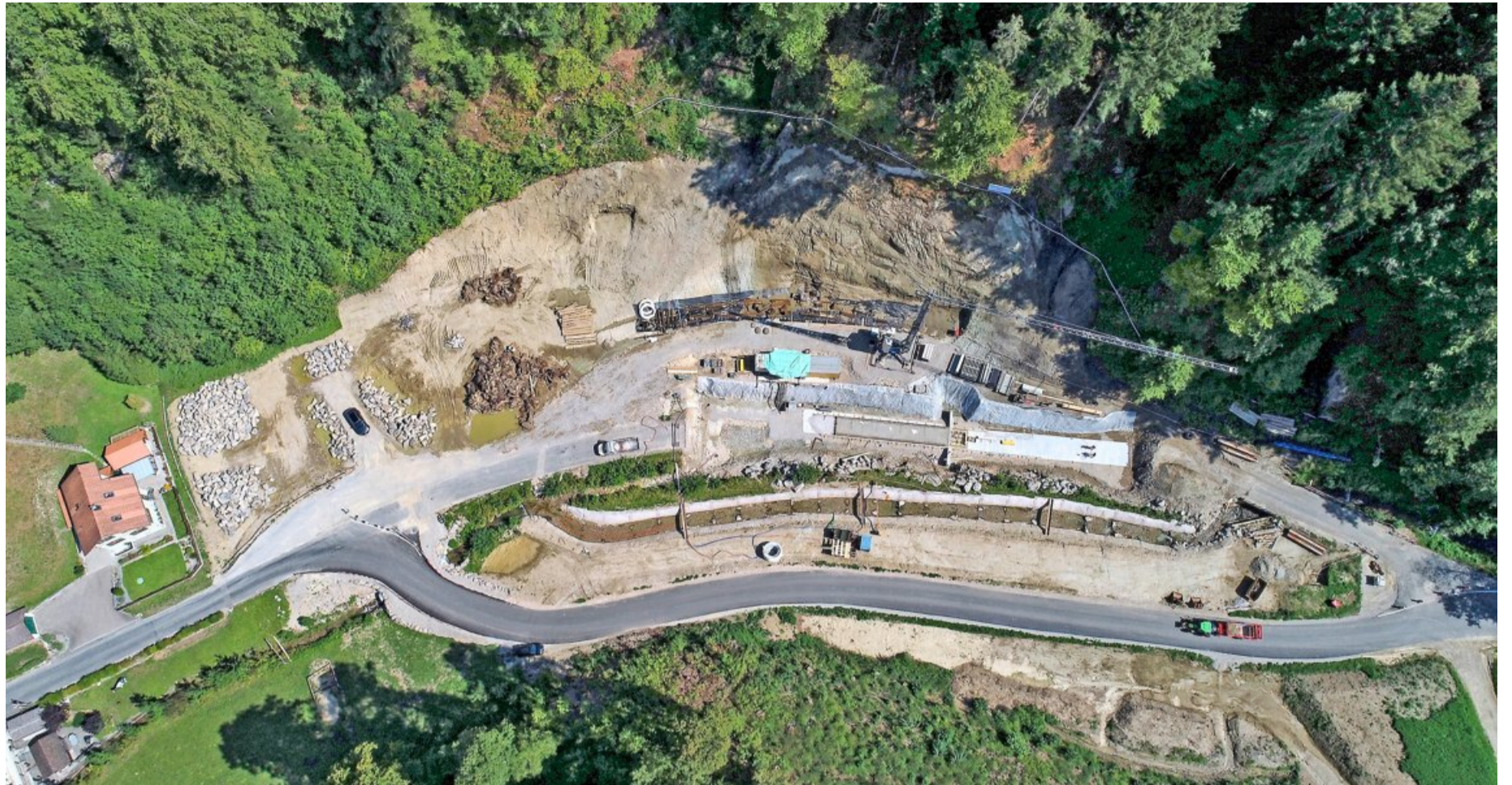
Das Luterbachtal ist auch während der Arbeiten erreichbar, jedoch musste die Strasse um etwa 25 Meter verschoben werden. Bis das Auslassbauwerk (Bildmitte) fertiggestellt ist, wird der Bach in einem Kanal um die Baustelle herumgeleitet.
