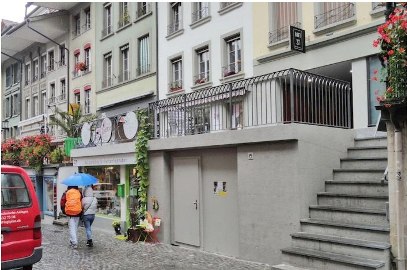
Verschlossener Zugang in der Altstadt zum Parkhaus.
